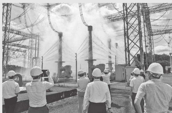
■西仙台変電所構内碍子洗浄
