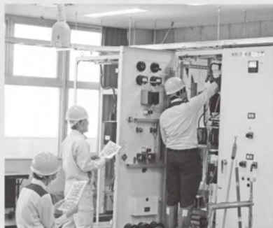
■短絡接地の取付け
